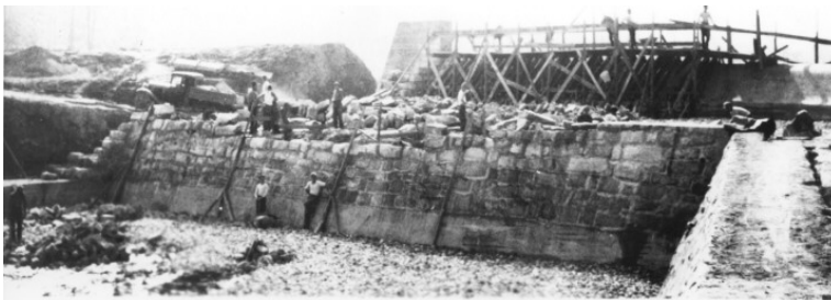
Pouring the weir - 1938
